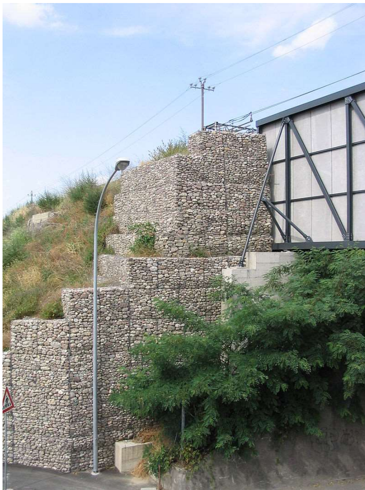
Figur 9. Exempel på gabioner som staplats på varandra och bildar en permanent stödkonstruktion (foto Acanfora CC BY-SA 3.0).
